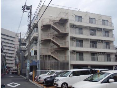
▲神奈川県横須賀市老健施設
