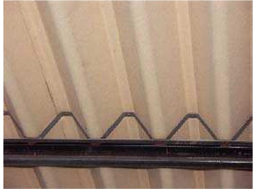
石綿含有屋根用折板裏断熱材
